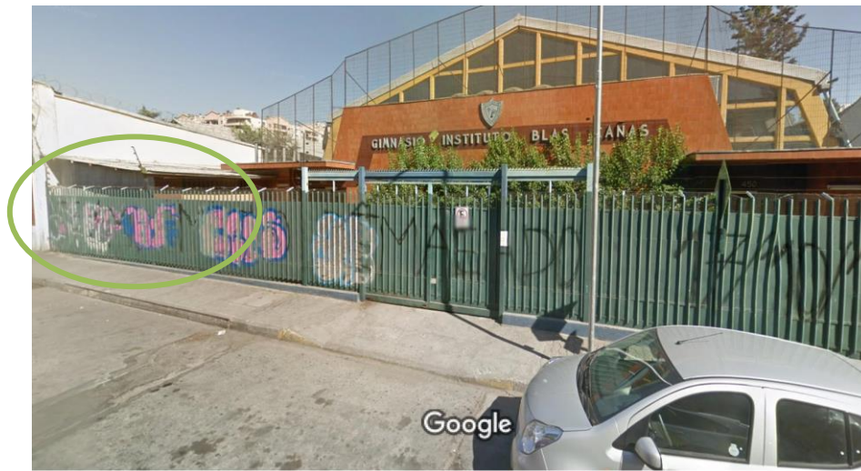
Acceso Principal de la Escuela Básica Blas Cañas por calle Blas Cañas y acceso a Gimnasio. Ambos accesos considerados como Salidas de Emergencias hacia Zona de Seguridad Externa. (Actualizar Foto)
